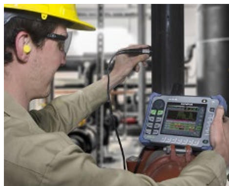
プラント配管検査
