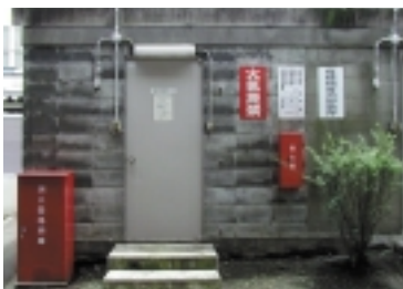
危険物保管庫
