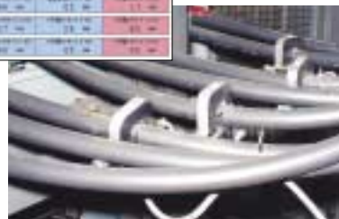
電力消費モニタリング
