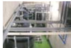
配管の地上化対策
