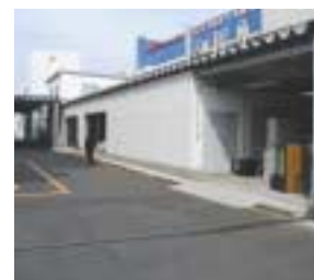
八王子リサイクルセンター
