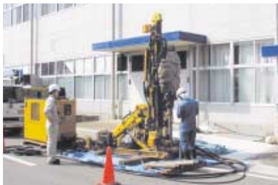
辰野サイトにおけるボーリング調査
