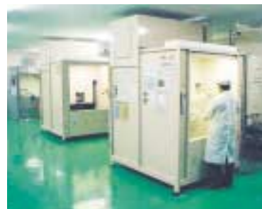
伊那事業場の粉体塗装室
