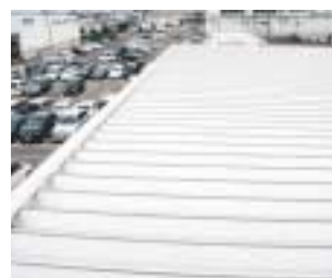
断熱材を使用した洗浄室の屋根
