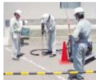
坂城サイトにおける土壌ガス吸引作業のためのコア抜き作業
