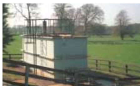
■排水処理装置
