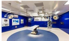
システムインテグレーション
