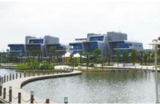
上海トレーニングセンター
