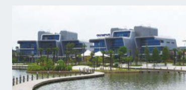
上海トレーニングセンター
