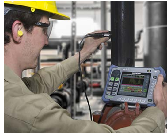
プラント配管検査
